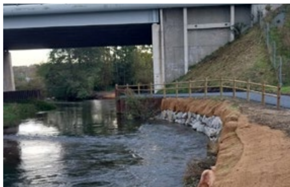
Travaux de réhabilitation de la voie douce. Consolidation des berges.
