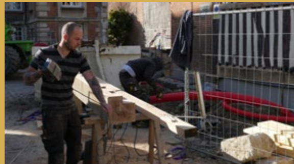
Sur l'ancienne maison, les pans de bois abimés sont traités ou remplacés dans les règles de l'art.
