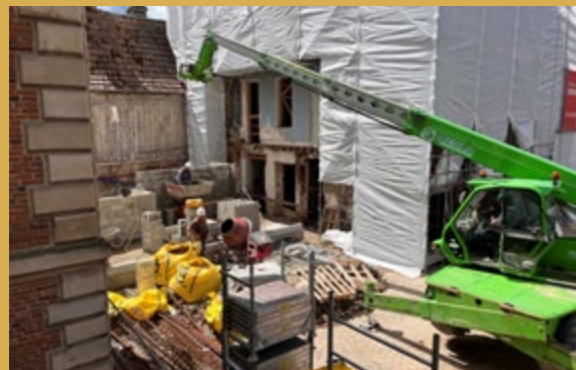
Sous l'échafaudage, les espaces intérieurs sont traités pendant que l'extérieur se prépare à recevoir un nouveau bâtiment.
