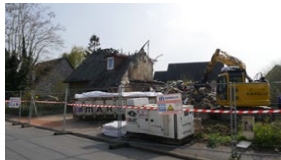
Rue du Long Clos - La maison endommagée a été détruite pour laisser place à une nouvelle construction. Un soulagement pour les riverains
